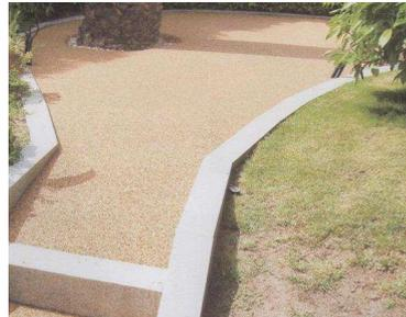
*Joint gazon avec dalles et stabilisé compacté*
