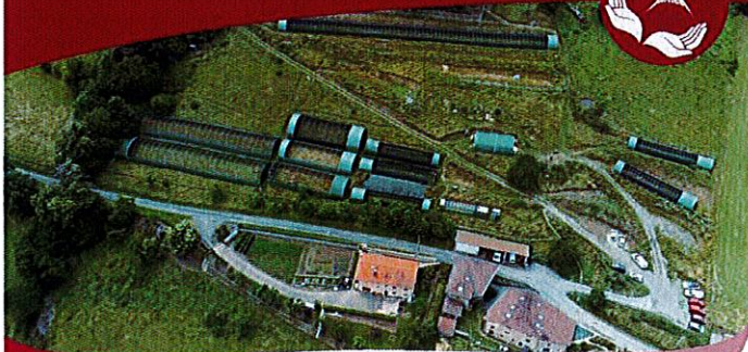
Vue du site de Saint-Forgeux
