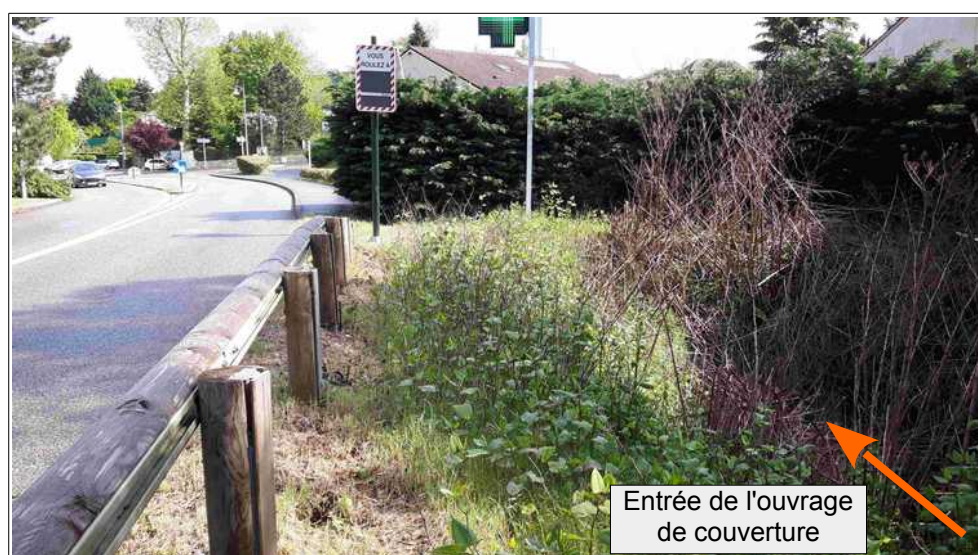
Figure III.9: couverture du ruisseau de Bérardier à l'amont de la pharmacie. En cas d'obstruction de l'ouvrage, le ruisseau peut se déverser sur la RD538.
