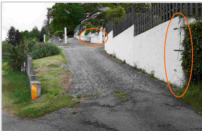
Figure III.15: signes de mouvements de terrain à l'amont du chemin de La Raze (murs de clôture fissurés et renforcés).
