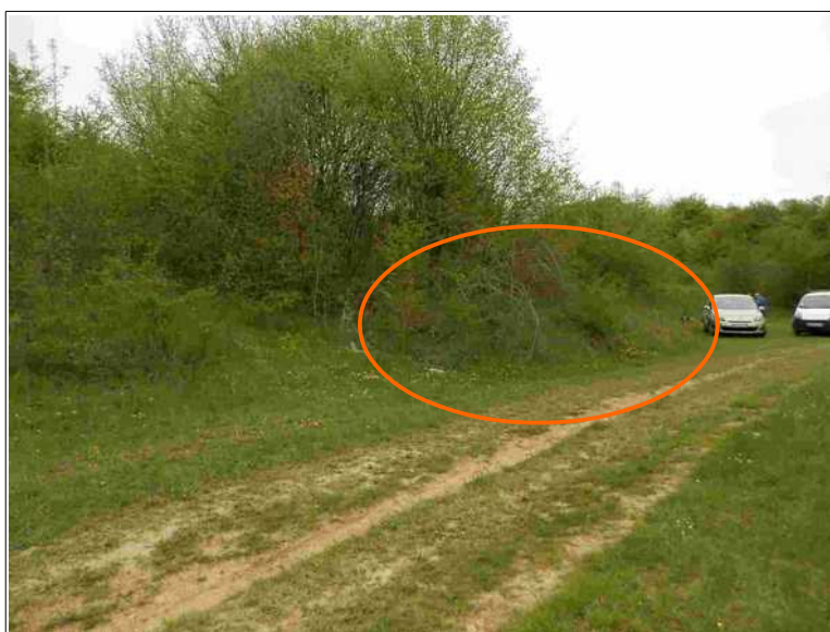
Figure III.17: languette du glissement de terrain du Brut.
