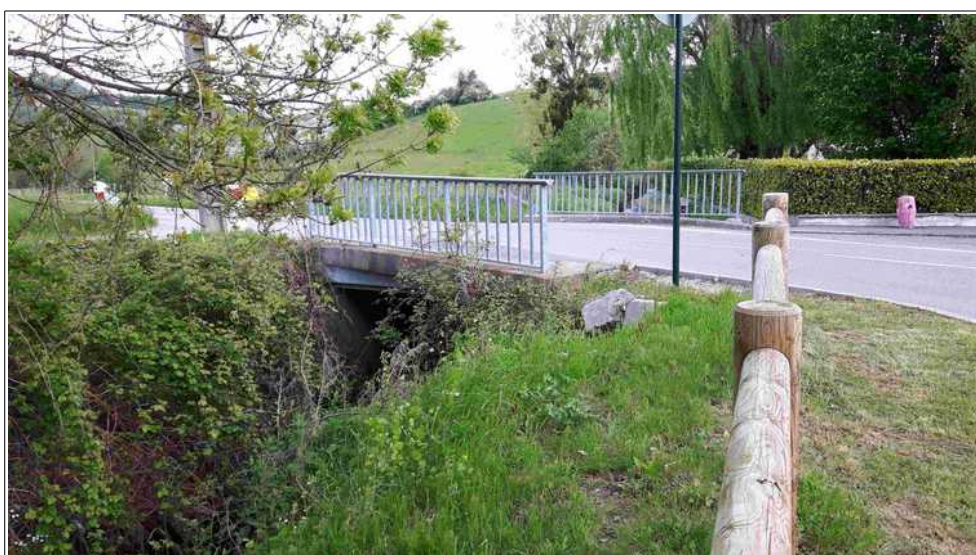
Figure III.8: franchissement de la RD167 à l'aval du village
