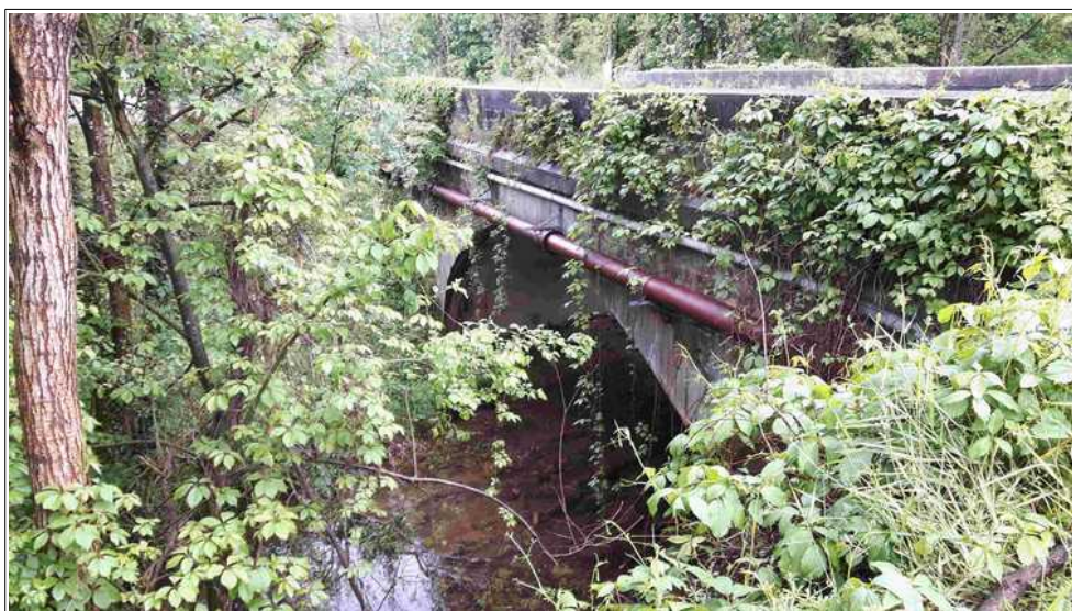
Figure III.4: pont de la RD538
