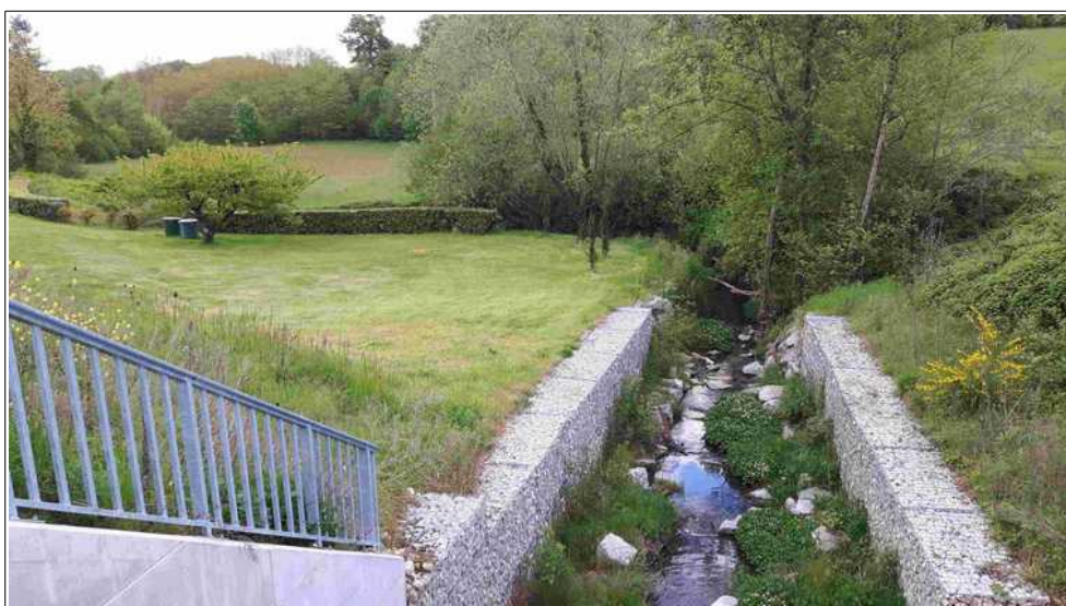
Figure III.11: vue du ruisseau de Bérardier à l'aval de la RD167a et de son champ d'inondation.
