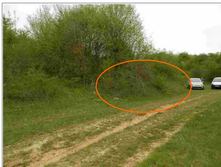
Figure III.17: langue du glissement de terrain du Brut.
