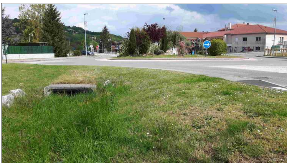
Figure III.6: franchissement du rond-point de la RD167. On notera l'encombrement apparent de l'ouvrage. A l'arrière, l'école maternelle inondable
